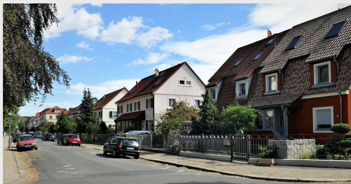
Die Zweifamilienhäuser wurden in den 1920er Jahren durch die "Bodenreformerische Siedlungsgemeinschaft Groß-Dresden" erbaut
